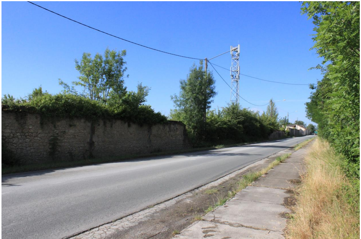
Figure 18. Mur et haie le long de la RD 48
