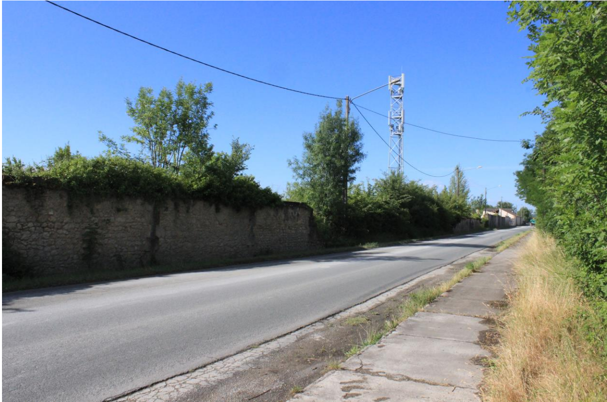
Figure 12. Mur et haie le long de la RD 48, depuis la cité ouvrière
