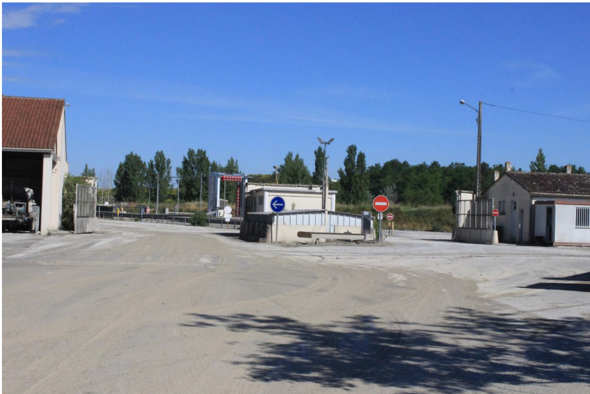
Figure 7. Entrée du site industriel commun
